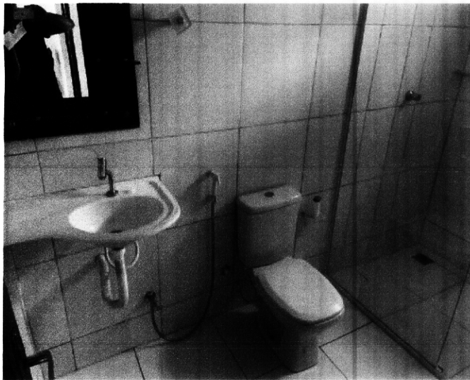
Banheiro 01 Fonte: Acervo Técnico (2024)
